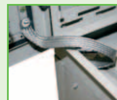
Ground and equipotential bonding
